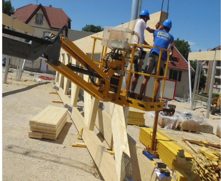
La société Charpente Pontarlier à la manœuvre avec la poutre de 32 m fabriquée par l'entreprise Simonin de Montlebon. Photo Fr.R.
